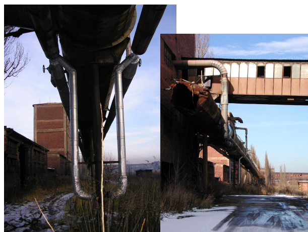
konec potrubí koksového plynu u drtírny
